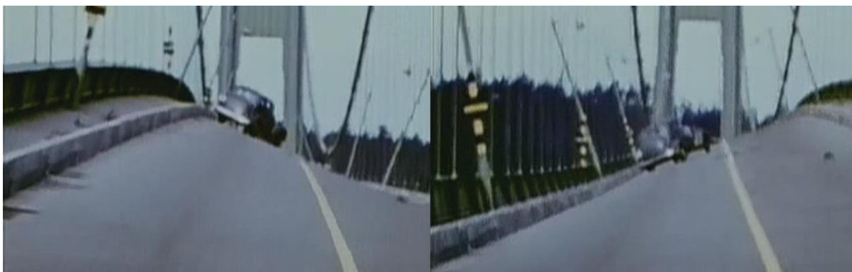
Obr. 7.15 Most Tacoma Narrows Bridge v krátkych okamihoch za sebou počas fúkania vetra a silného krútenia mosta
